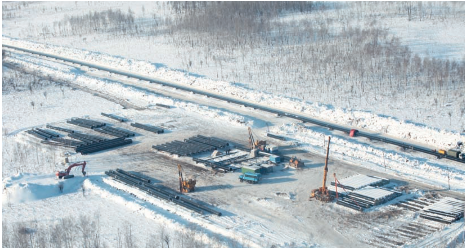
Под особым контролем у технадзора объекты линейной части газопроводов
